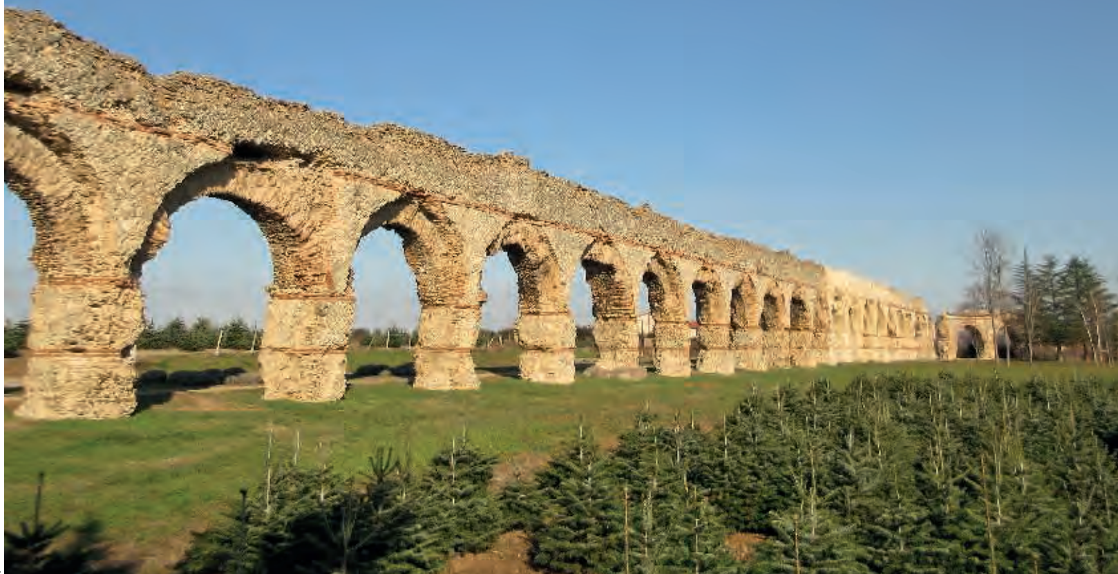
Vestiges de l'aqueduc romain du Gier à Chaponost, alimentant Lyon.
