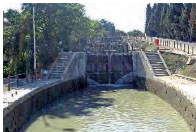
L'escalier d'Écluses (8) de Fonseranes. Dénivellation de 22 m sur une longueur de 312 m.
