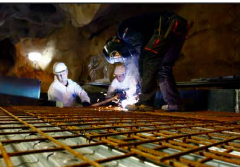
La soudure des tiges métalliques.
